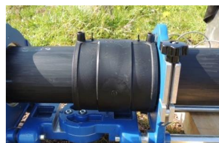
Saldatura ad elettrofusione
