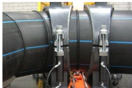
Saldatura ad elemento termico per contatto
